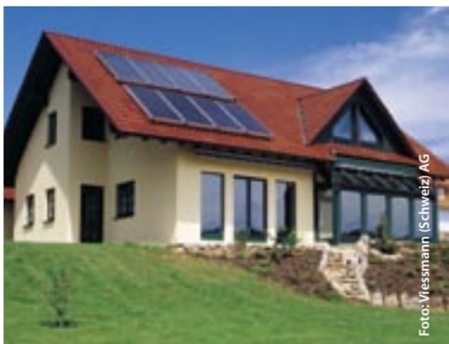
Bei einer Heizungsanlage werden im Normalfall der alte Heizkessel, der Ölbrenner und die Steuerung durch den Heizungsinstallateur ausgebaut und durch neue Geräte ersetzt. Zur Sanierung gehört auch der Austausch des alten Boilers durch einen modernen Wassererwärmer. Solarkollektoren für die Warmwassererwärmung lassen sich sehr gut in ein System mit einer Ölheizung integrieren.
